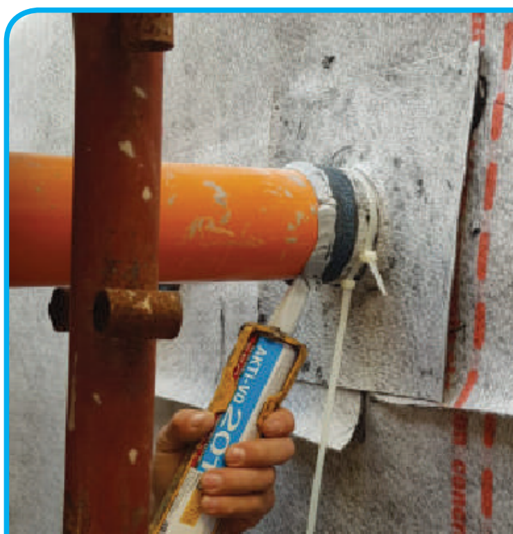
Impermeabilização de tubulação com selante hidroexpansível e sistema AMPHIBIA
