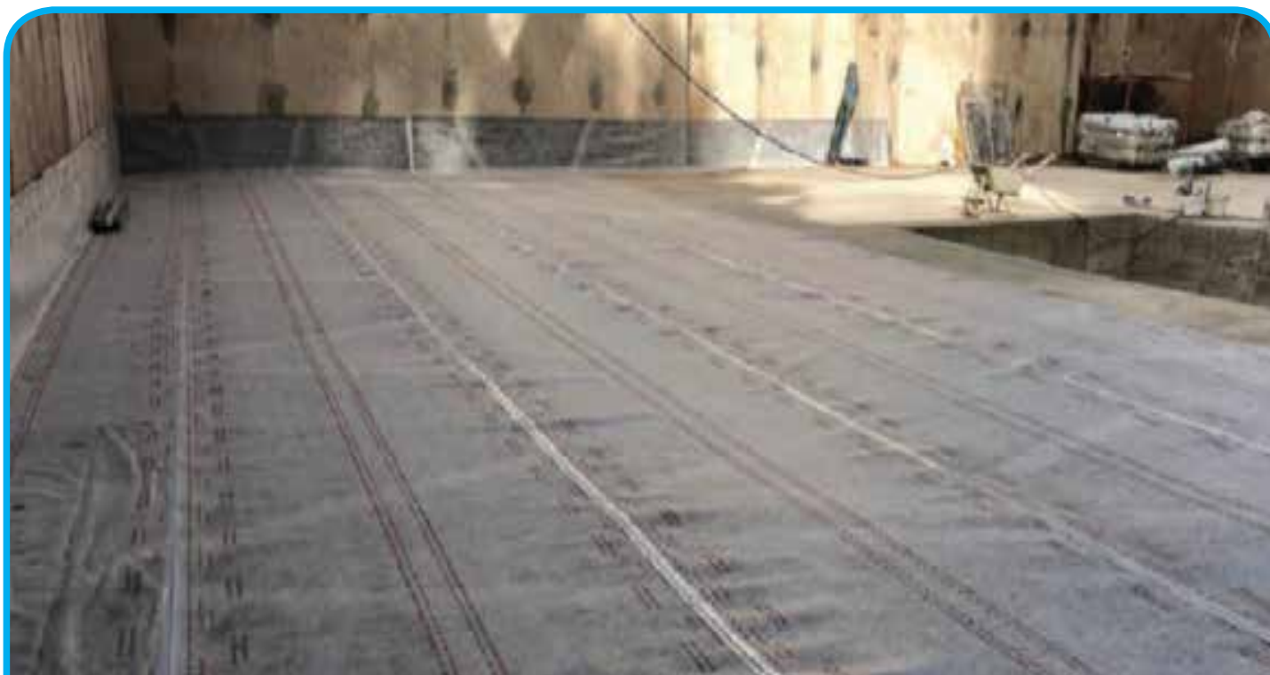
Canto de 90° no caso de instalação em estruturas de concreto existentes com o sistema AMPHIBIA
