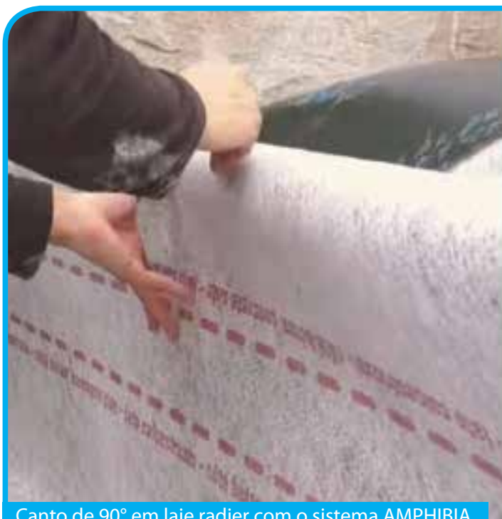
Canto de 90° em laje radier com o sistema AMPHIBIA
